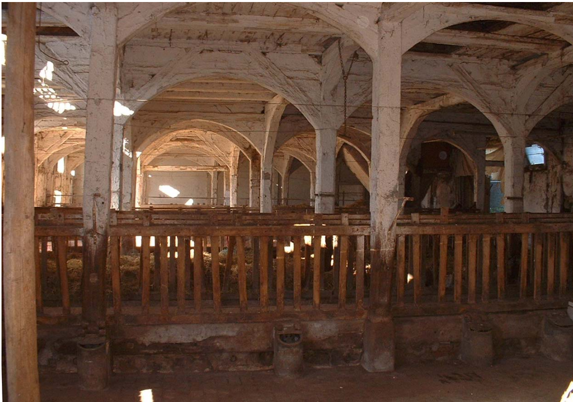
Abb. 9: Ehemaliger Viehstall mit denkmalgeschützter Stützkonstruktion
